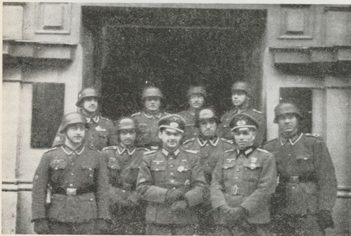
Destacamento de la Guardia Civil de Riga
