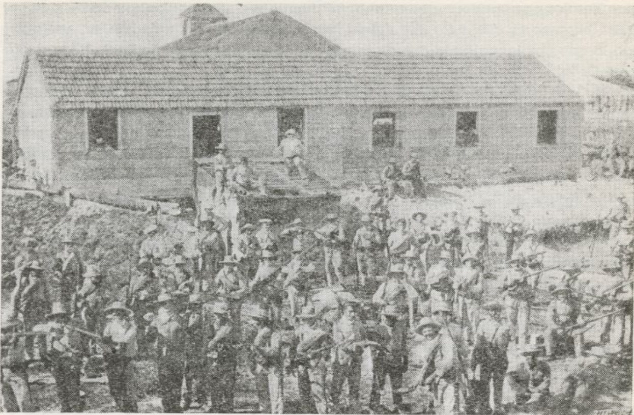
GUARDIA CIVIL DE CUBA.—Casa-cuartel de Hoyo Colorado después de ser defendida de los ataques de los insurrectos
