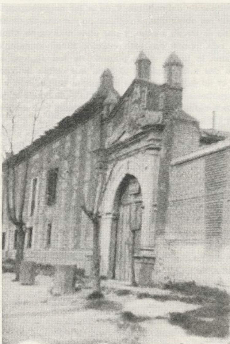
Fachada ruinosa del antiguo edificio donde estuvo instalada la Casa-cuartel de la Guardia Civil en Adanero (Avila)
