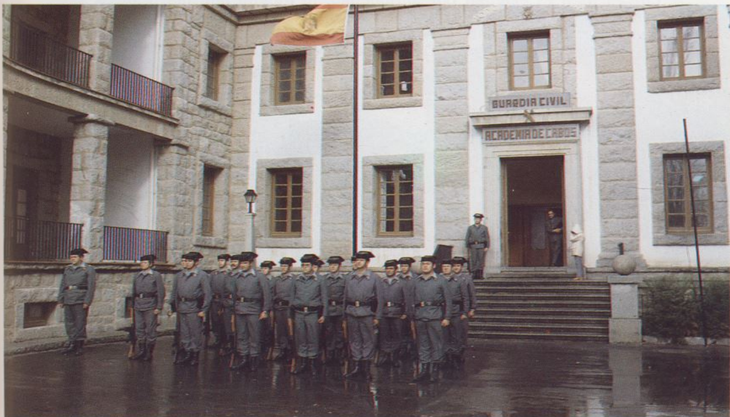
Fachada del edificio de la Academia de Cabos de Guadarrama (Madrid)
