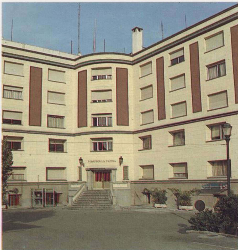
Fachada del antiguo Centro de Instrucción
