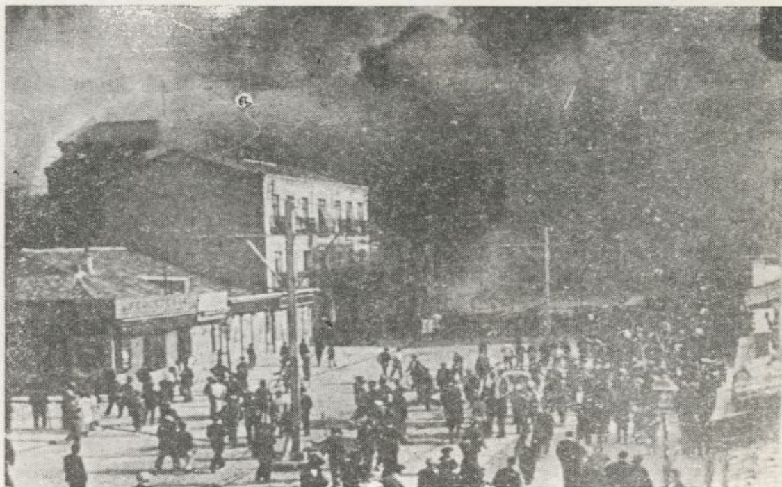
Incendio del colegio de Las Maravillas, en Cuatro Caminos
