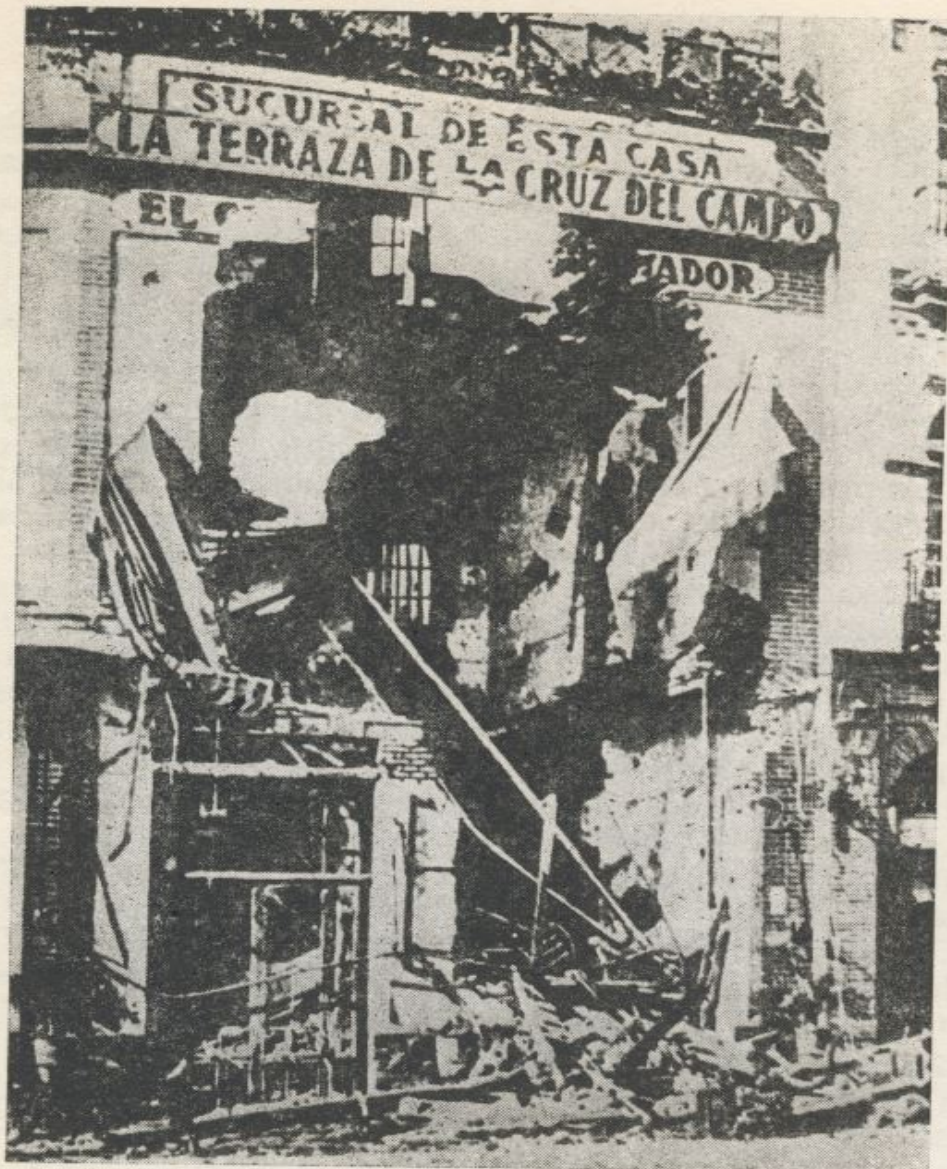
Estado en que quedó la «Casa Cornelio» después de ser cañoneada
