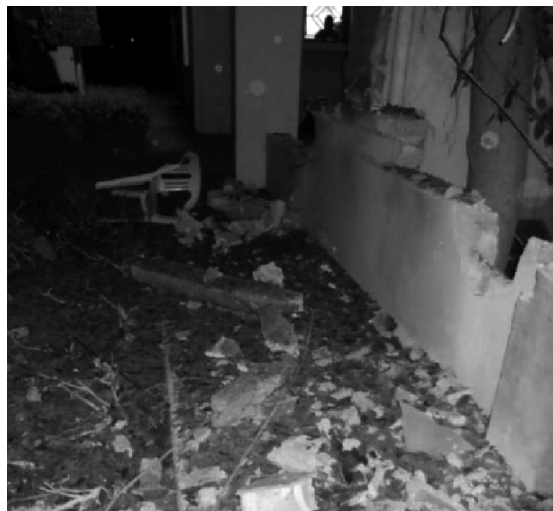
Imagen 3: Muros del Consulado de Benghazi.
