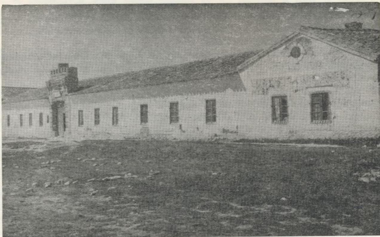
Casa-cuartel de la Guardia Civil de Meco (Madrid). El Puesto fue creado en los primeros años de la fundación, y el edificio, ocupado por el Cuerpo en 1909
