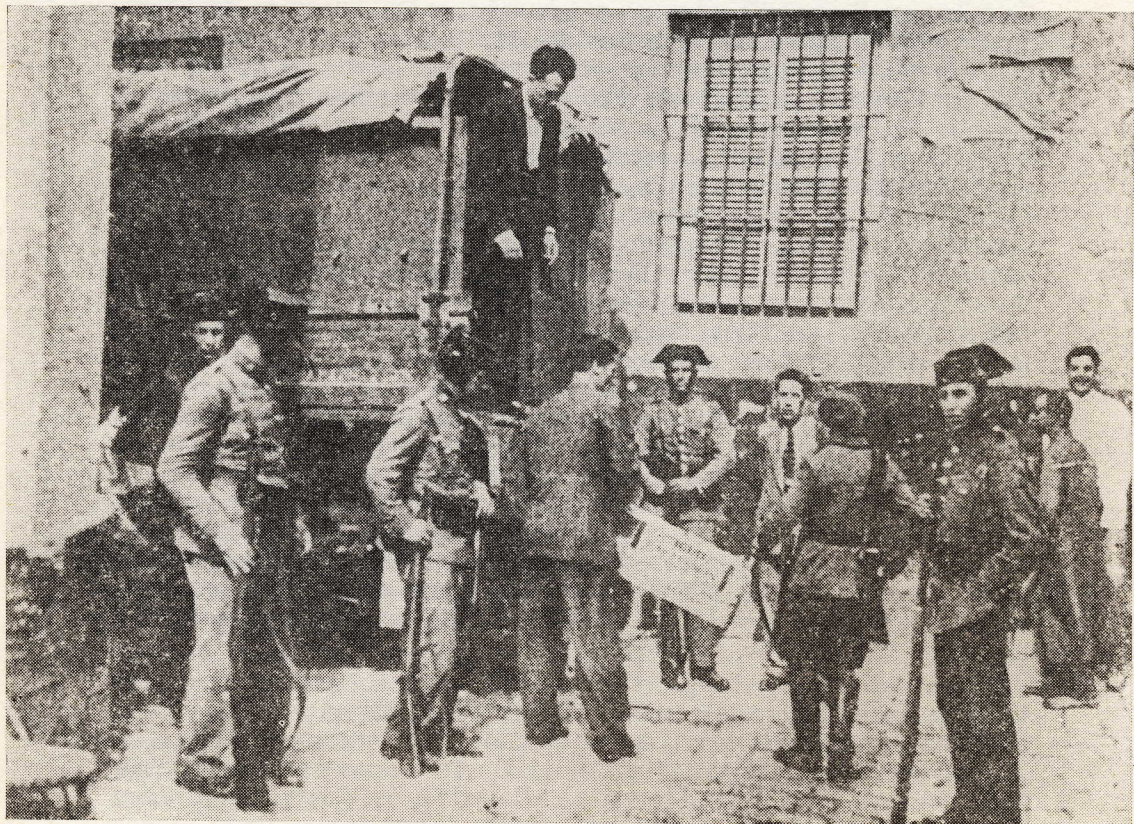
Incantación de explosivos en una cochera de Sevilla
